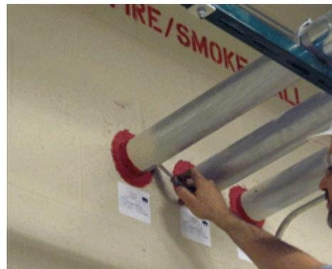
Ilustración 4. Sellado pases de muro y placa
